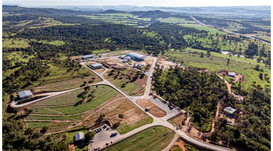
Visão aérea do Site Cezarina da Enaex, em Goiás, que comporta novas Plantas de Emulsão e Sistemas de Iniciação Eletrônica, depósitos estratégicos e estrutura de serviços Foto: Maycon Moura
